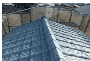
H邸 瓦葺替え工事
