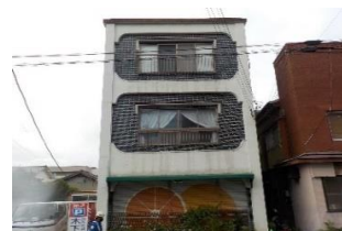
Yビル 外壁塗替工事
